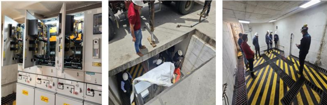
Ilustración 3. Soterramiento del alimentador 1721 - SE17
