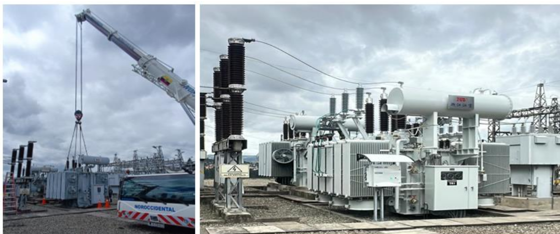
Ilustración 4. Reemplazo de TR1 en la SE04
