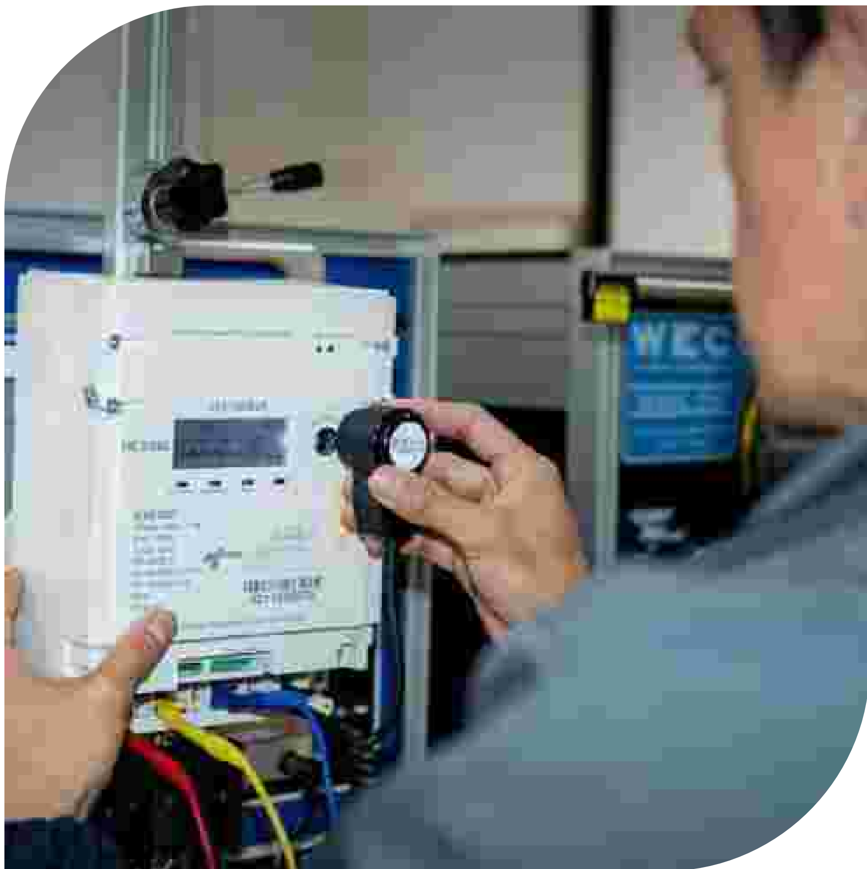
Instalación de medidores AMI
