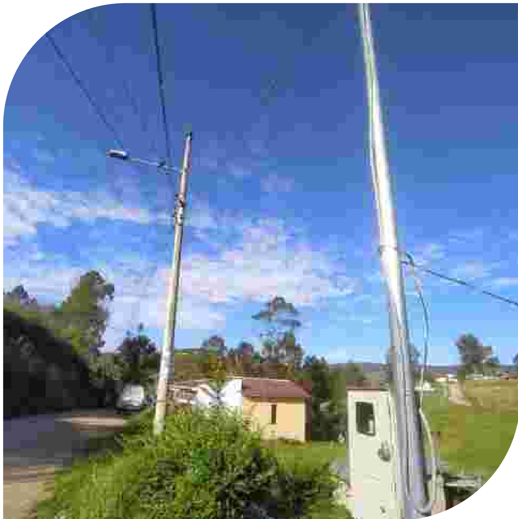
Cambio de medidores y acometidas, Nabón
