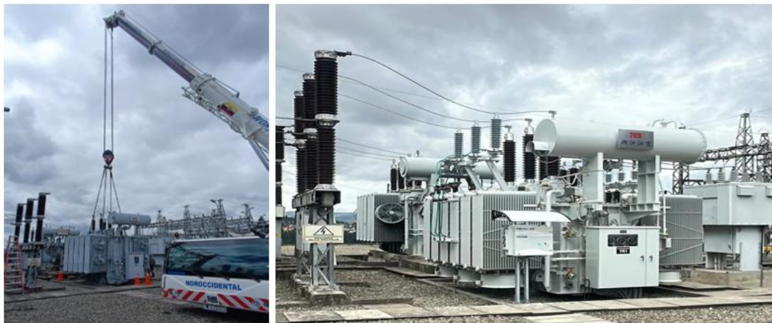
Ilustración 4. Reemplazo de TR1 en la SE04
