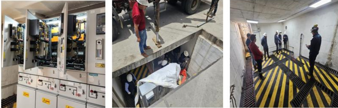
Ilustración 3. Soterramiento del alimentador 1721 - SE17
