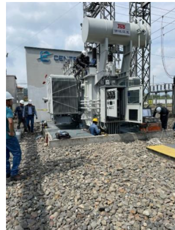
Pruebas del transformador TR2 SE 50
