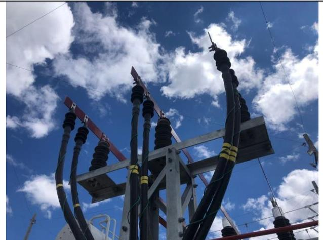
Barra de 22kV de salida de transformador de potencia
