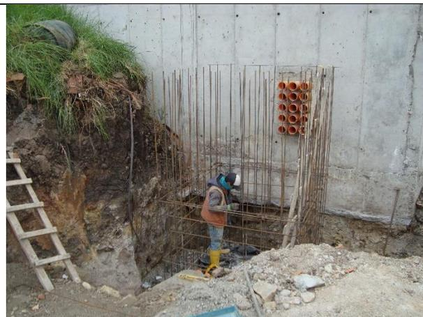
Armado de acero de refuerzo para cámaras eléctricas de banco de ductos de 22 kV en calle S/N posterior a subestación
