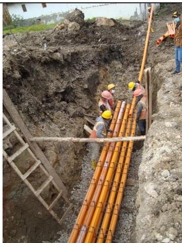
Colocación de acero de refuerzo y tubería de PVC para ductos banco de ductos de 22 kV en calle S/N posterior a subestación
