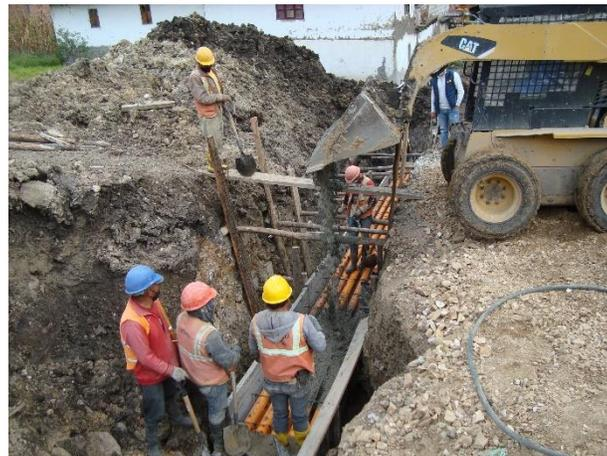
Fundición para banco de ductos de 22 kV en calle S/N posterior a subestación
