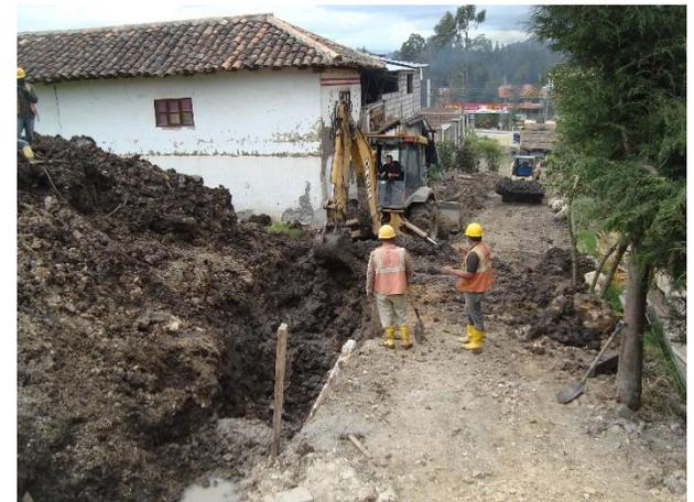
Excavación para banco de ductos de 22 kV en calle S/N posterior a subestación
