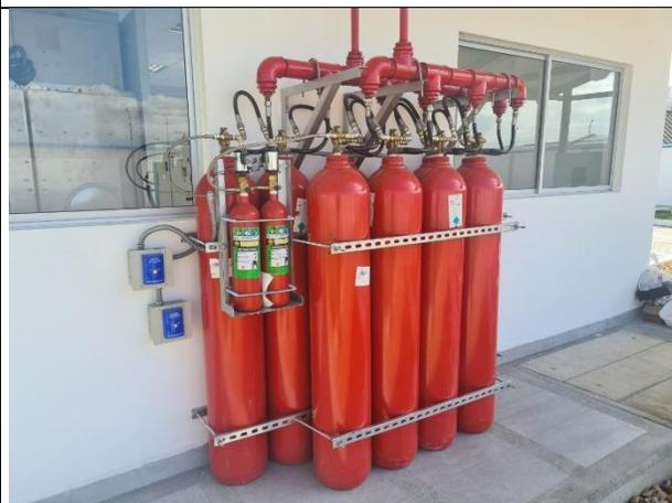
Cilindros de CO2, modulo de release y manguerassa de alta presión
