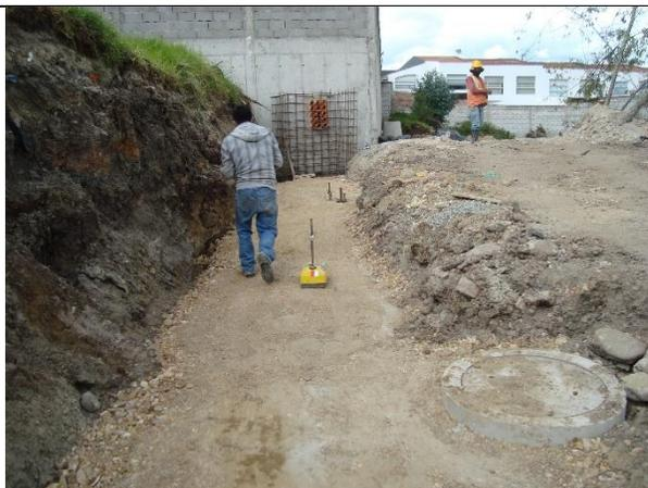
Toma de densidades de material de mejoramiento sobre banco de ductos de 22 kV en calle S/N posterior a subestación
