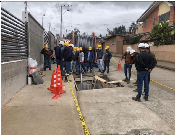
Tendido de cables de 69kV
