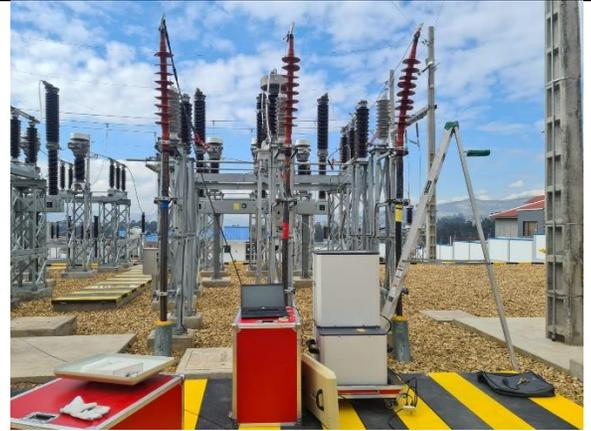
Pruebas VLF de cable de 69 kV
