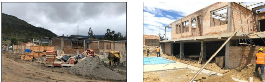
Construcción nuevas oficinas – Cantón Oña
