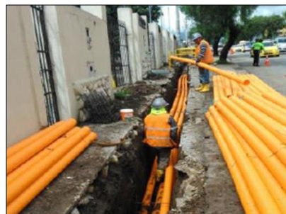
Trabajos de soterramiento - nueva línea entre las subestaciones 01 y 04
