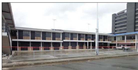
Construcción de las bodegas para grupos operativos
