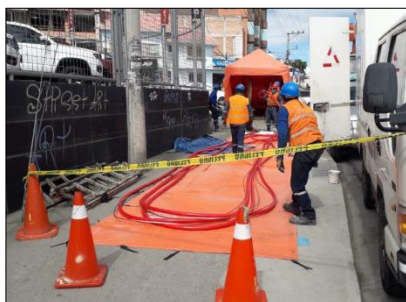
Trabajos de soterramiento - nueva línea entre las subestaciones 01 y 04
