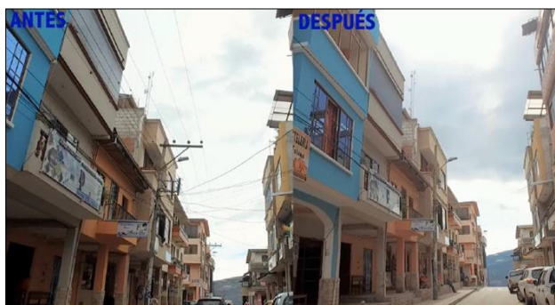
Soterramiento y Repotenciación - redes Centro Cantonal Santa Isabel
