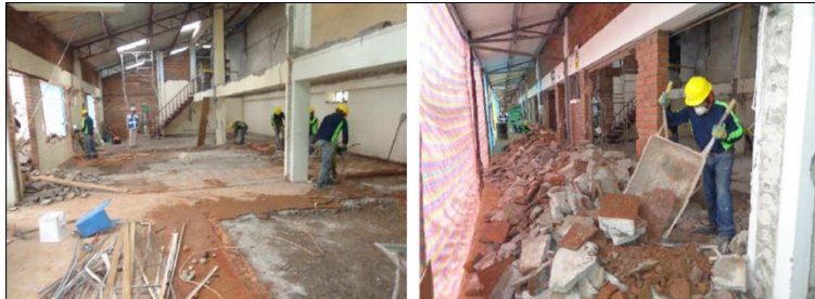
Construcción de nuevas oficinas del Departamento Administrativo
