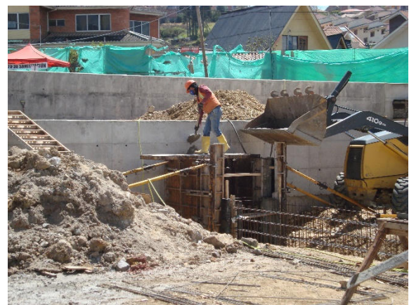
Fundición de caja de pasada PB15
