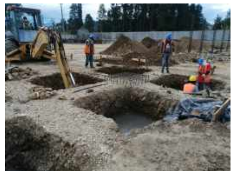
Replanteo, Nivelación de casa de control y garita de guardianía Excavación a máquina y mano para zapatas de casa de control y garita de guardianía
