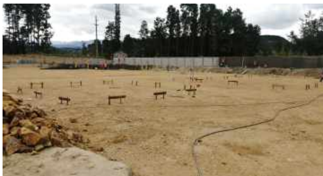
Replanteo, Nivelación de casa de control y garita de guardianía Excavación a máquina y mano para zapatas de casa de control y garita de guardianía
