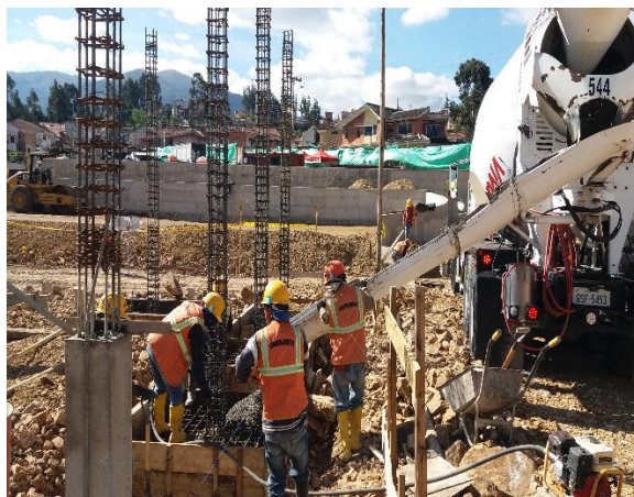
Fundición de zapatas casa de control
