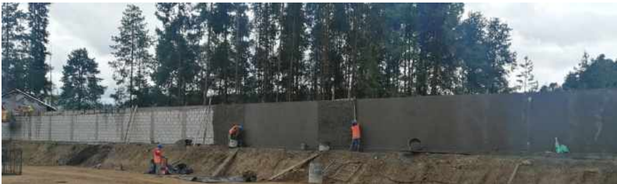
Construcción de cerramiento perimetral
