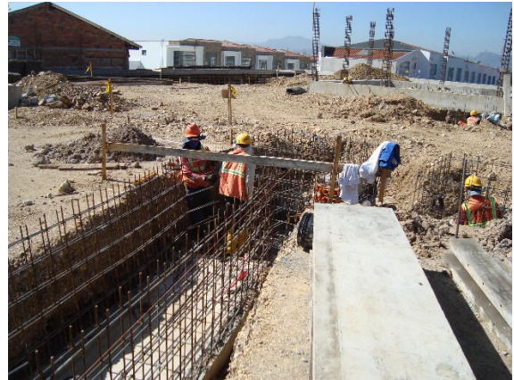
Armado de hierros de canaletas (casa de control) Armado de hierros canaleta y cajas pasada PB15- PB4
