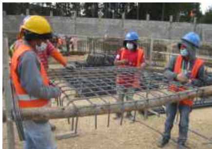
Armado de hierro para estructuras de casa de control y de patio de 69 KV
