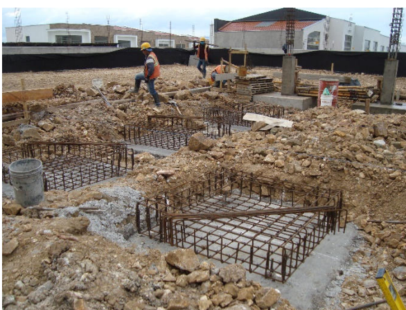
Armado de hierros de zapatas (casa de control)
