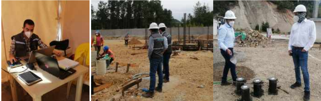
Permanencia de Fiscalización en obra Toma de muestras de hormigón de zapatas de casa de control para control de calidad
