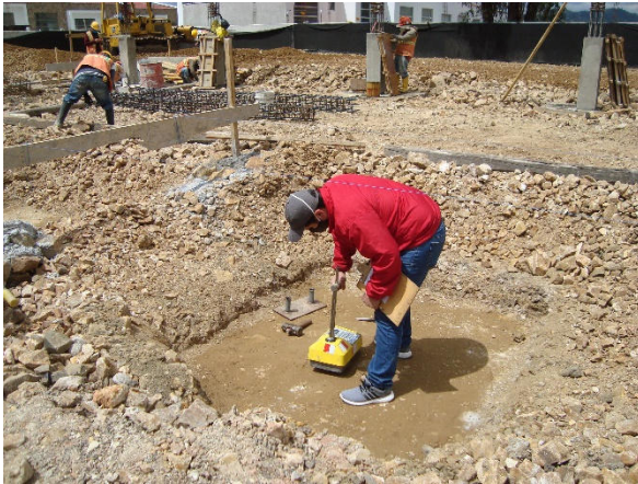
Toma de densidades (zapata casa de control)
