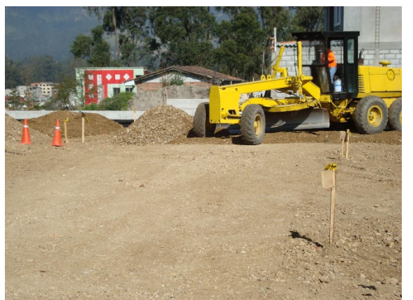
Conformación de vías internas de subestación
