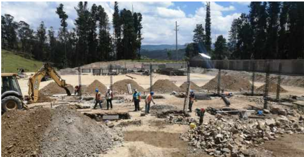
Construcción de cimentación de casa de control y garita de guardianía
