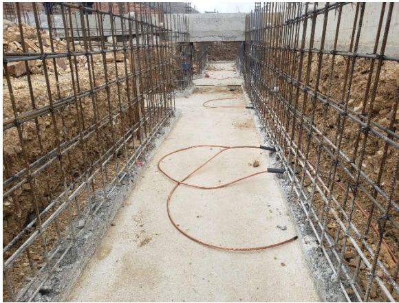
Colocación de malla de SPT en Casa de Control
