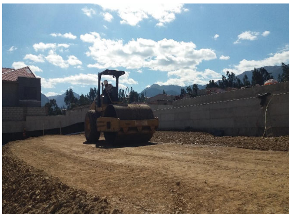
Compactación de plataforma N.T.E 2643
