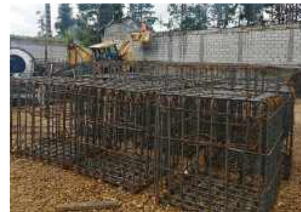
Armado de hierro para estructuras de casa de control y de patio de 69 KV
