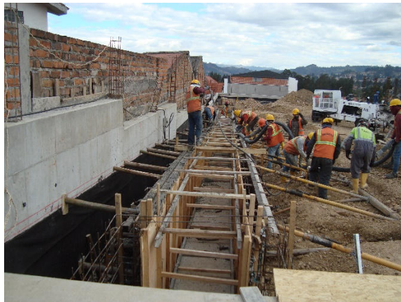
Fundición de paredes de canaleta PB10-PB9
