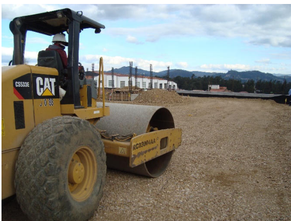
Compactación de vías internas de subestación
