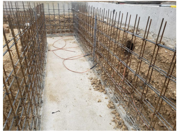
Colocación de malla de SPT en Casa de Control
