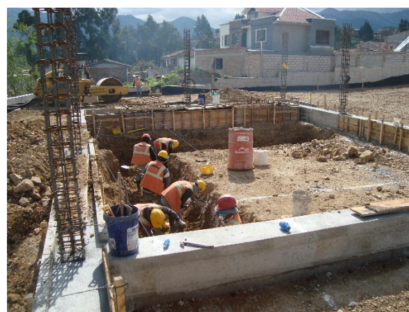
Excavación para canaletas (casa de control)
