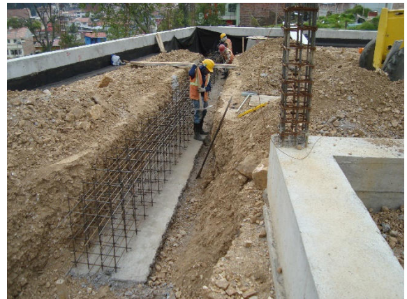
Armado de hierros banco de ductos PB17-PB18
