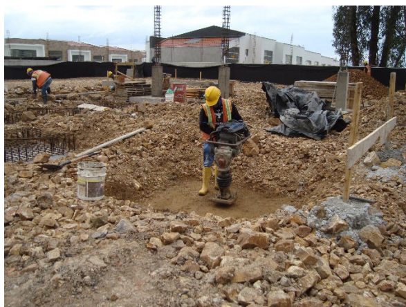
Relleno compactado para zapatas (casa de control)
