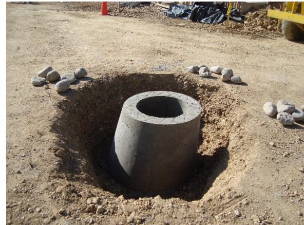
Fundición de pozo de registro
