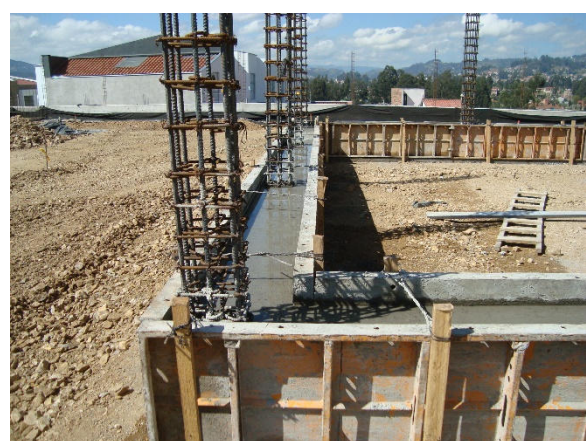
Fundición de vigas de cimentación (casa de control)
