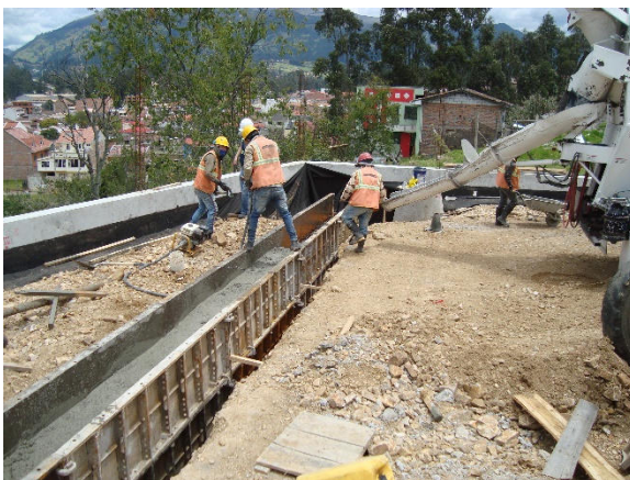
Fundición de banco de ductos PB17-PB18
