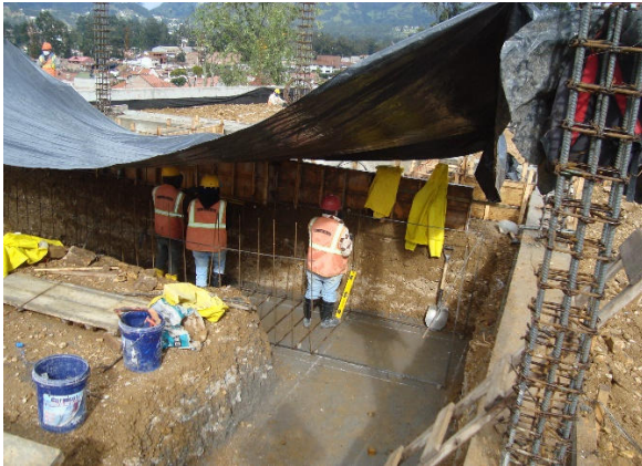
Armado de hierros de canaletas (casa de control) Armado de hierros canaleta y cajas pasada PB15- PB4
