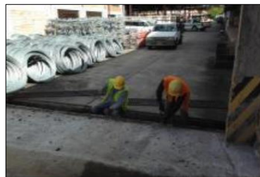
Acceso a zona de bodegas
