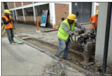
Arreglo parqueadero posterior
